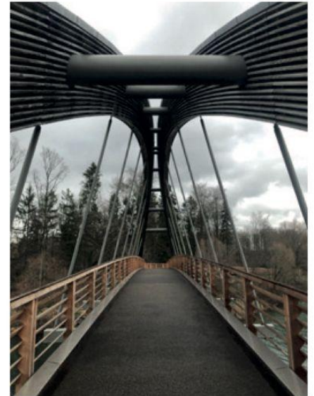
5 Vue sur la rampe du Pont Rotary: pente douce la rendant accessible aux vélos et aux rollers.
