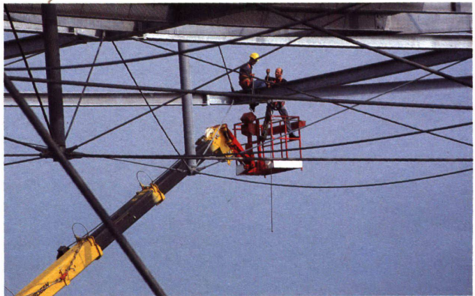
Yverdon – der Ort der Sorgen – ist der spannendste Bauplatz der Expo.02. Im See entsteht der Träger der «Wolke». 12 500 Düsen oder 31 000 Düsen? Die rollende Plaung wird entscheiden
